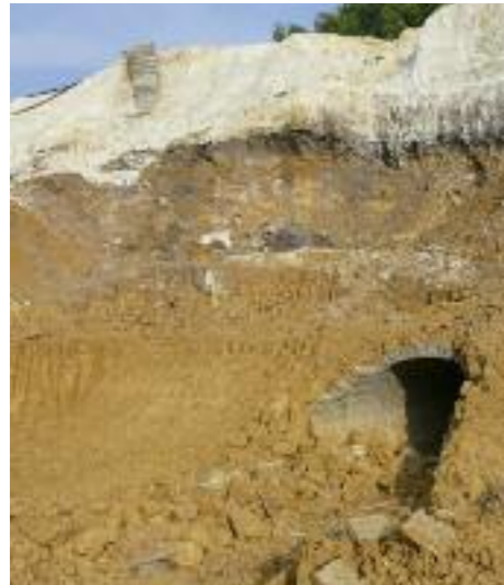
Angebaggerte alte Strecke des Untertageabbaus
